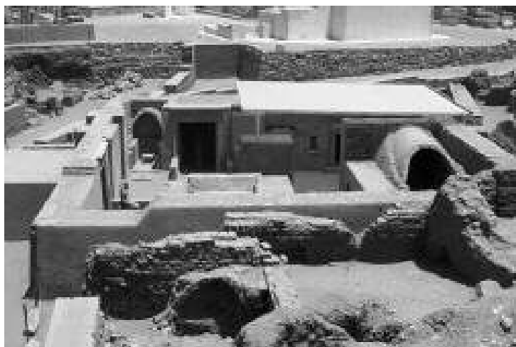
Figura 2. Una simple techumbre construida para cubrir una parte particularmente importante de un sitio arqueológico situado cerca de un museo. Un ligero declive y un canalón permiten dirigir el agua lejos de la zona protegida y evitan que se produzcan problemas de humedad sobre las paredes. Costo reducido pero preservación eficaz. Todas las fotografías de este capítulo pertenecen al autor, Stefan Michalski, Instituto Canadiense de Conservación, salvo las figuras 9 y 10, tomadas en el marco de proyectos para la UNESCO o el ICOM en El Cairo, Asuán y Kuwait (ciudad) entre 1986 y 2002.
