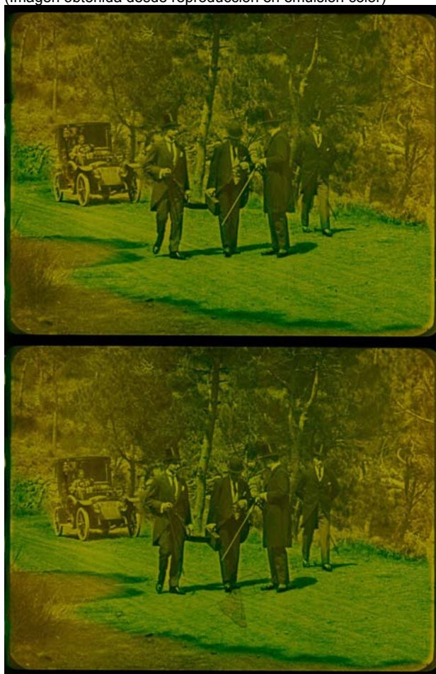
Figura 31. Película teñida en amarillo y virada en azul. La humedad ha corrido el colorante empleado en el virado. (Imagen obtenida desde reproducción en emulsión color)
